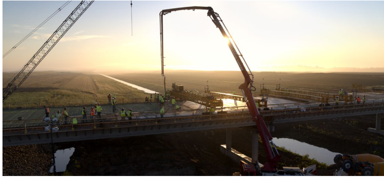
County Road - Deck Pour
